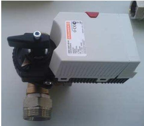
После установки привода на трехходовой клапан необходимо проверить направление вращения привода (см. инструкцию на приводы серии 225). При работе трехходового клапана на открытие подачи теплоносителя от котла привод должен вращаться против часовой стрелке. При работе трехходового клапана на открытие подачи обратного теплоносителя (работа на смещивание), привод должен вращаться по часовой стрелке. Переключатель №3 на приводе должен быть установлен в положение “ON”.
