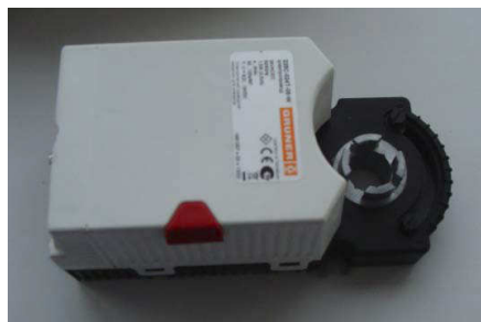
Сервопривод трехходового клапана 225C-024T-05W
